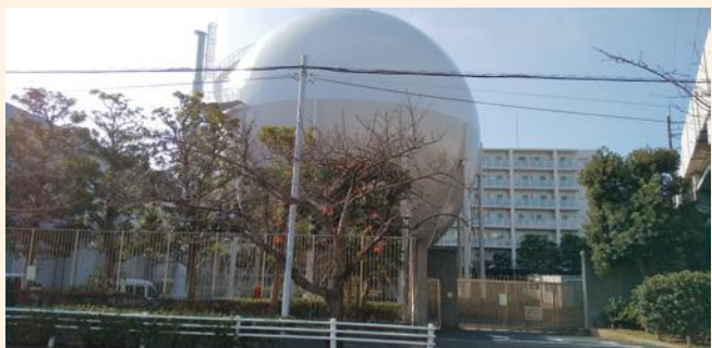
巨大なガス貯蔵タンク
